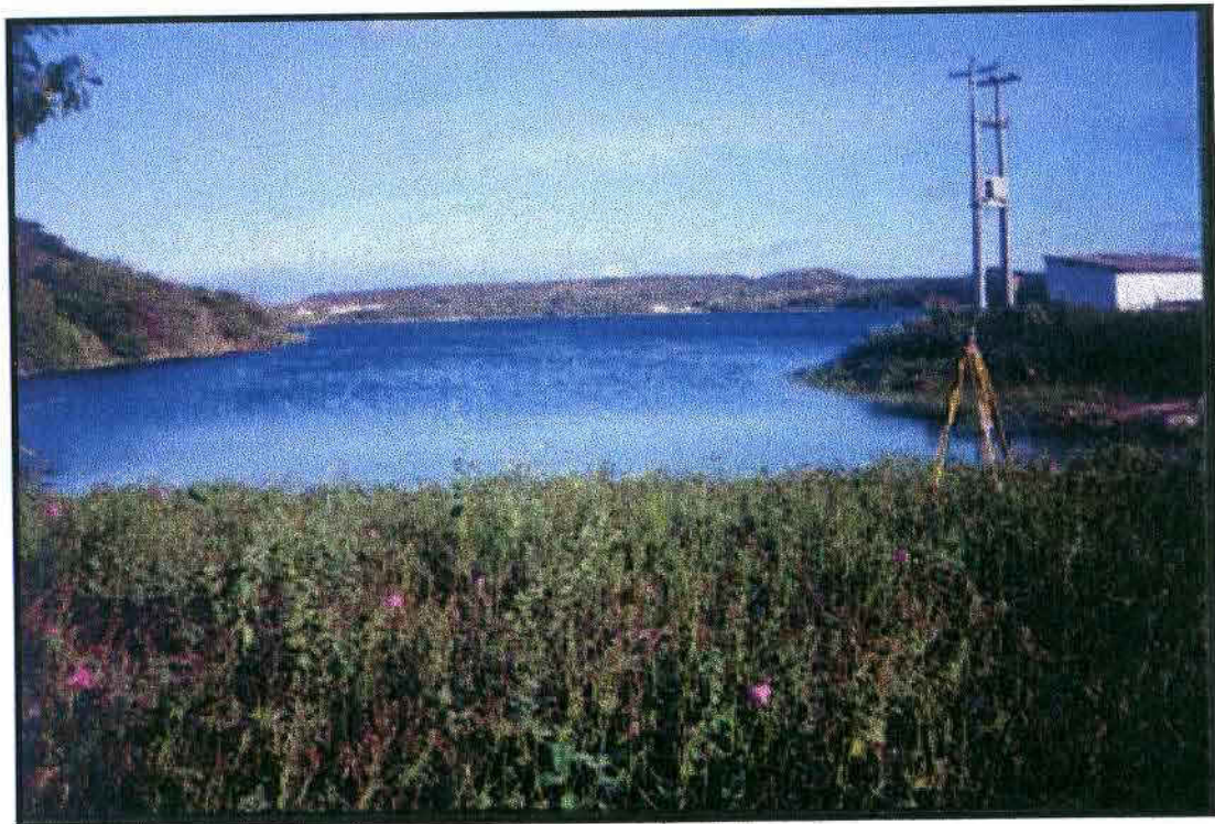
Foto 02 – Vista da área para implantação da estação de bombeamento principal. Observa-se ao lado a estação elevatória da adutora existente.
