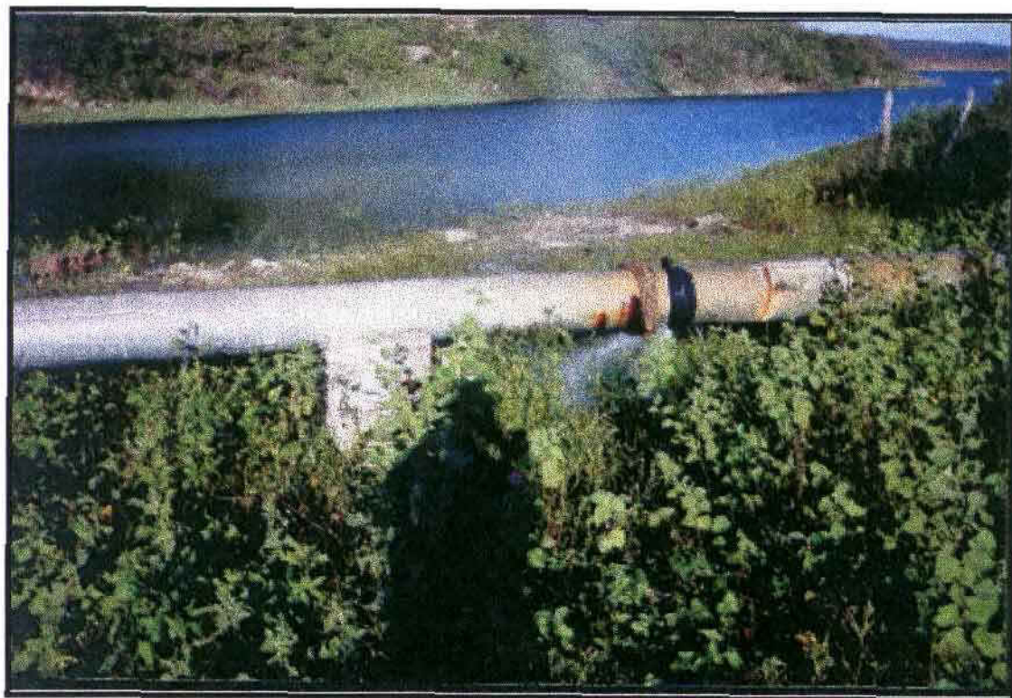
Foto 03 – Situação da adutora existente no trecho próximo à captação.
