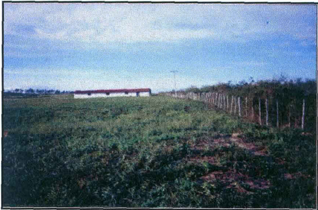
Foto 05 – Vista de caminhamento da adutora projetada no sentido Norte-Sul.
