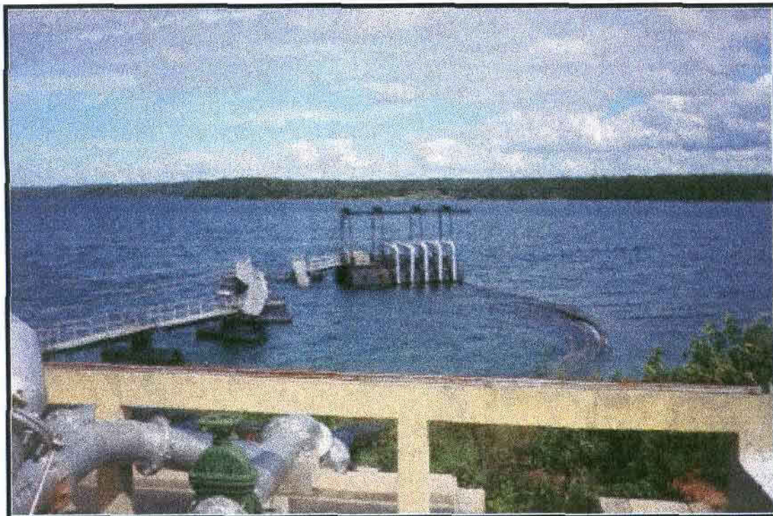
Foto 12 – Estação de bombeamento flutuante do sistema adutor da Ibiapaba (vê-se no detalhe os problemas que ocorrem com grande frequência na passarela de acesso. Estes problemas são causados pelos fortes ventos).
