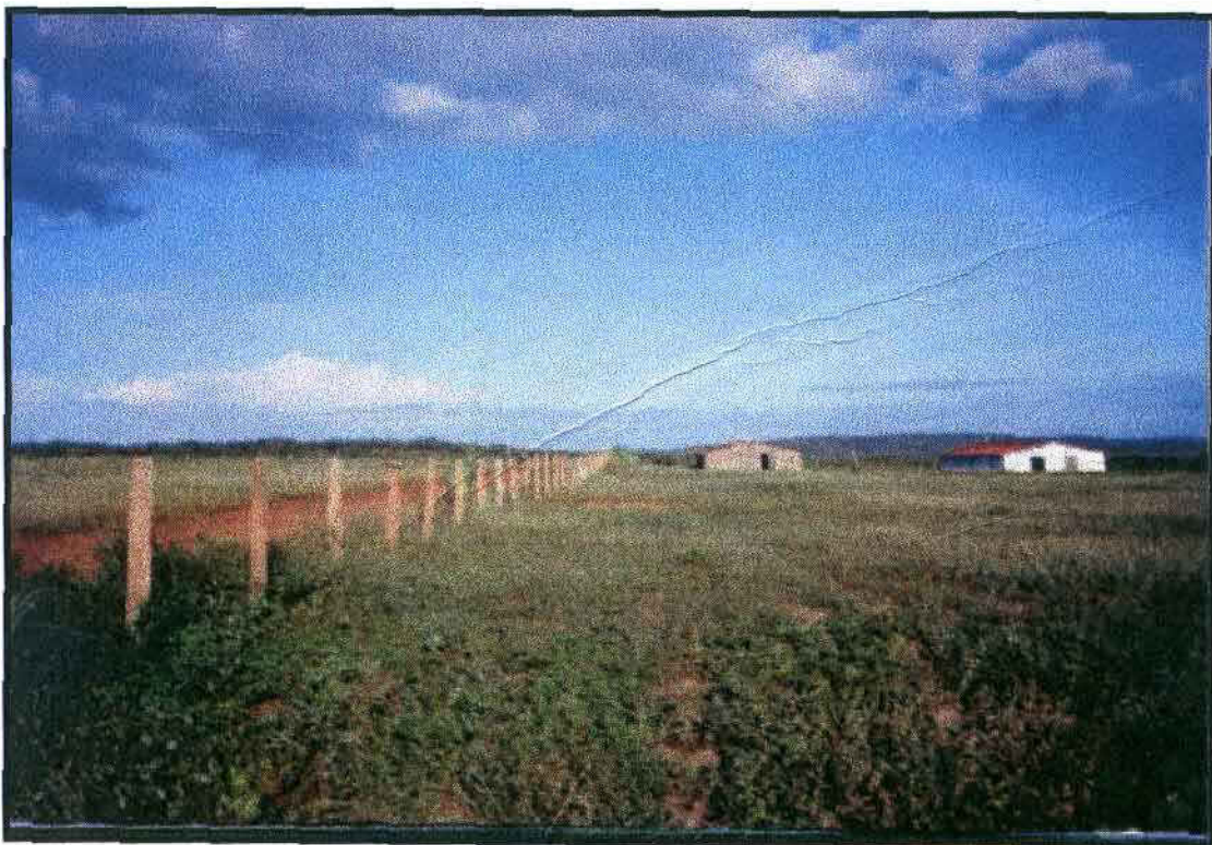
Foto 06 – Área de chegada da adutora.
